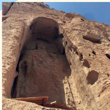
破壊された東大仏の現在の様子。補強作業によって東大仏龕（がん）は2011年に崩壊の危機を免れた ©Nagaoka/UNESCO
